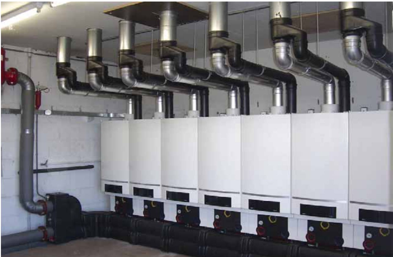
Instalación de 7 calderas en cascada Logamax plus GB 162
