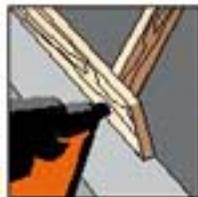
Fijación de viga laminada estructural con la clavadora neumática **PASLODE 6625/160 SQ** y clavo Ø 4,6 mm x160 mm.
