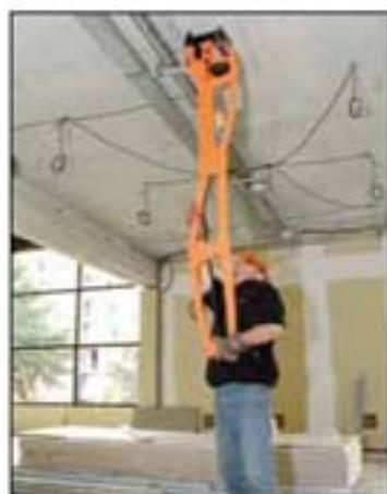
Clavado en techo de grapas multicable con la percha SPIT PULSA LIFT
