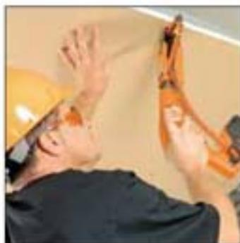
Con adaptador Speed 55 y tornillos en cinta.
