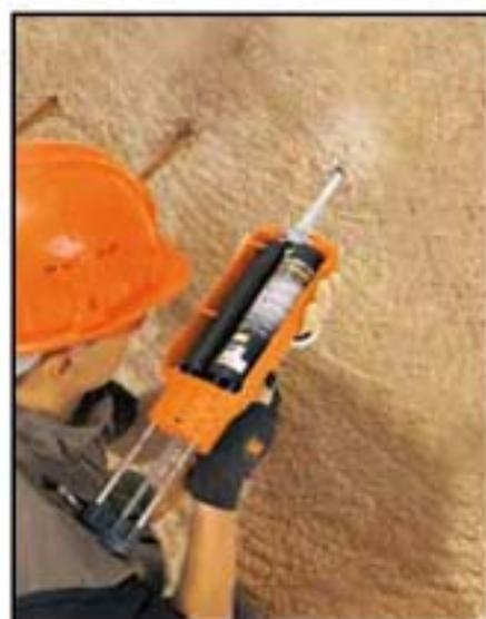
Para las inyecciones en serie, utilice la pistola de inyección neumática
